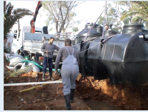
Εκσκαφή - προετοιμασία - αλφάδειασμα εδάφους
