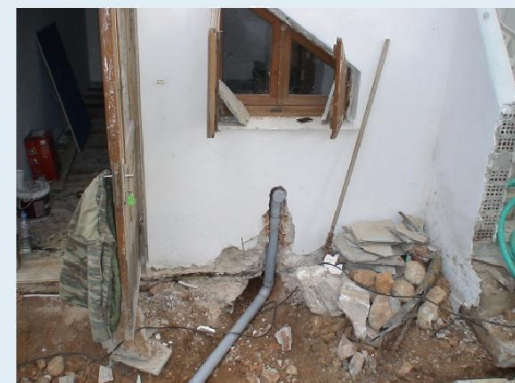
Σύνδεση της αποχέτευσης - Επιβεβαίωση κλήσης για φυσική ροή
