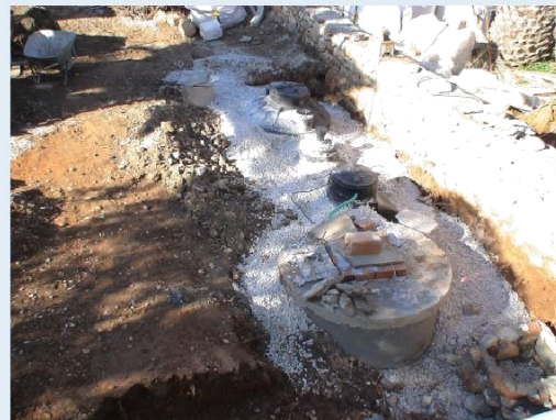
Γέμισμα βιολογικού και πλήρωση του κενού για προστασία
