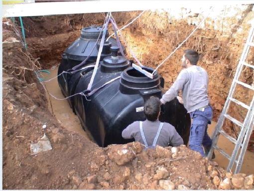
Τοποθέτηση και αλφάδειασμα βιολογικού
