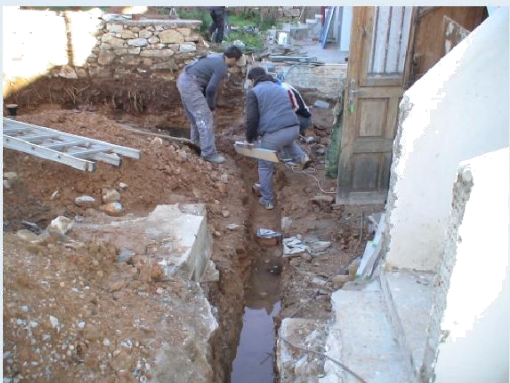
Σύνδεση της αποχέτευσης - Επιβεβαίωση κλήσης για φυσική ροή
