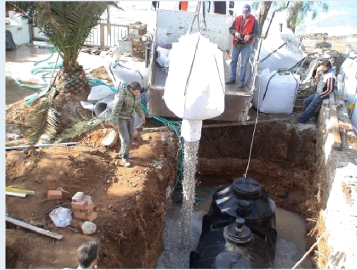
Τοποθέτηση και αλφάδειασμα βιολογικού
