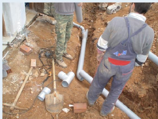
Σύνδεση της αποχέτευσης - Επιβεβαίωση κλήσης για φυσική ροή
