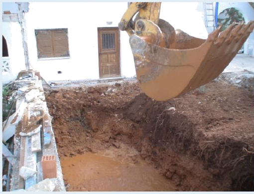
Εκσκαφή - προετοιμασία - αλφάδειασμα εδάφους
