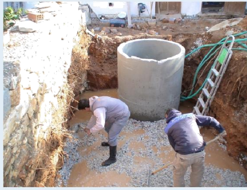
Εκσκαφή - προετοιμασία - αλφάδειασμα εδάφους
