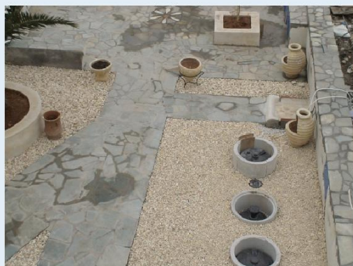
Σύνδεση της αποχέτευσης - Επιβεβαίωση κλήσης για φυσική ροή
