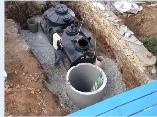
Τοποθέτηση και αλφάδειασμα βιολογικού
