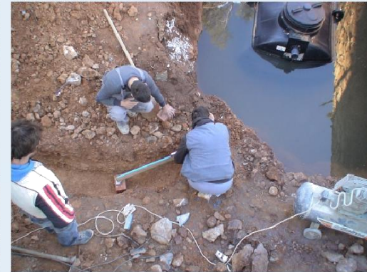
Γέμισμα βιολογικού και πλήρωση του κενού για προστασία
