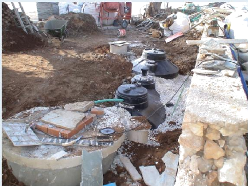
Γέμισμα βιολογικού και πλήρωση του κενού για προστασία
